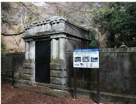
奈良市水道開業 100 の遺産、旧高地区配水池施設 = 2022 年 1 月、奈良市雑司町
