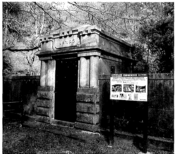
◀奈良市水道の創業時代に建設された旧配水池施設。100年を迎えた。
